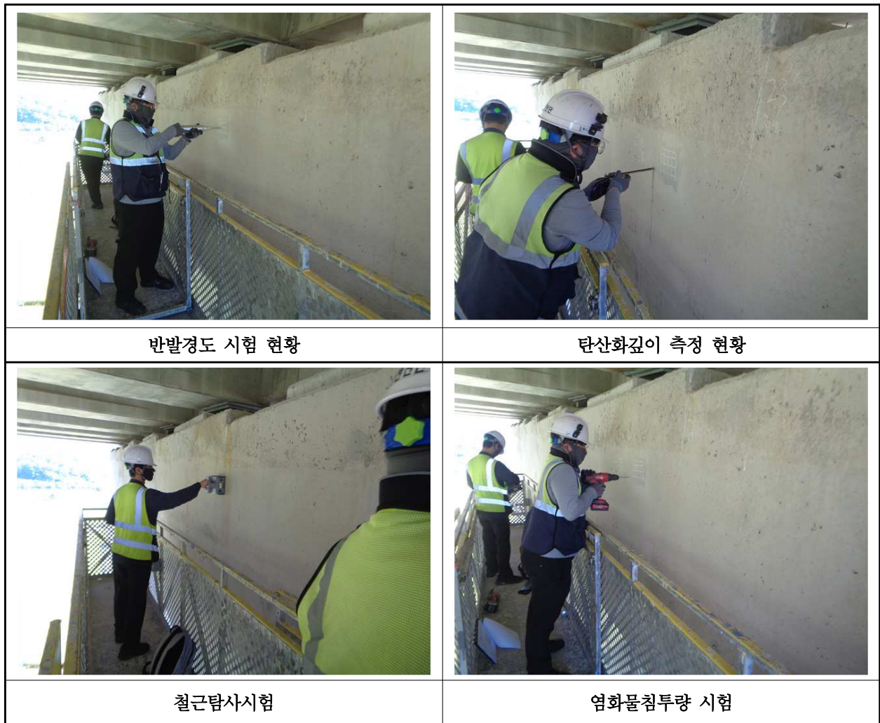
【사진 6.4.1】 콘크리트 내구성조사 현황
