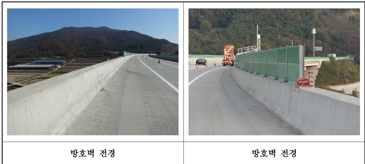
【사진 6.3.23】 방호벽 및 중앙분리대 전경
