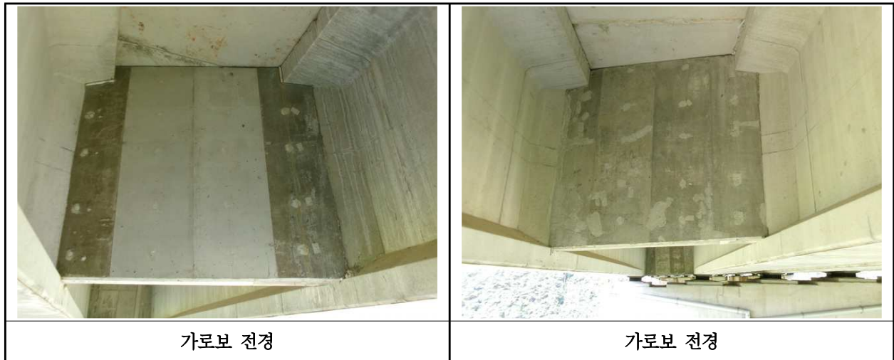
【사진 6.3.6】 가로보 전경
