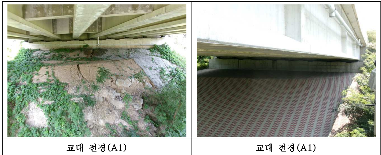
【사진 6.3.8】 교대 전경
