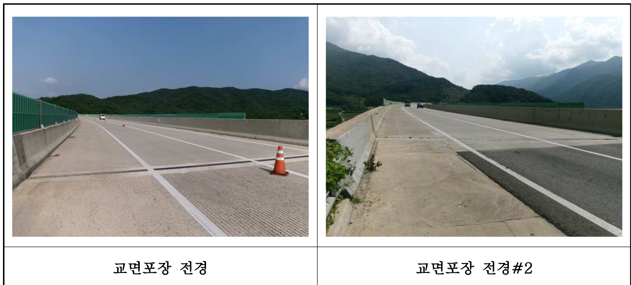
【사진 6.3.19】 교면포장 전경
