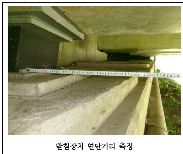
【사진 6.3.14】 교량받침장치 연단거리측정
