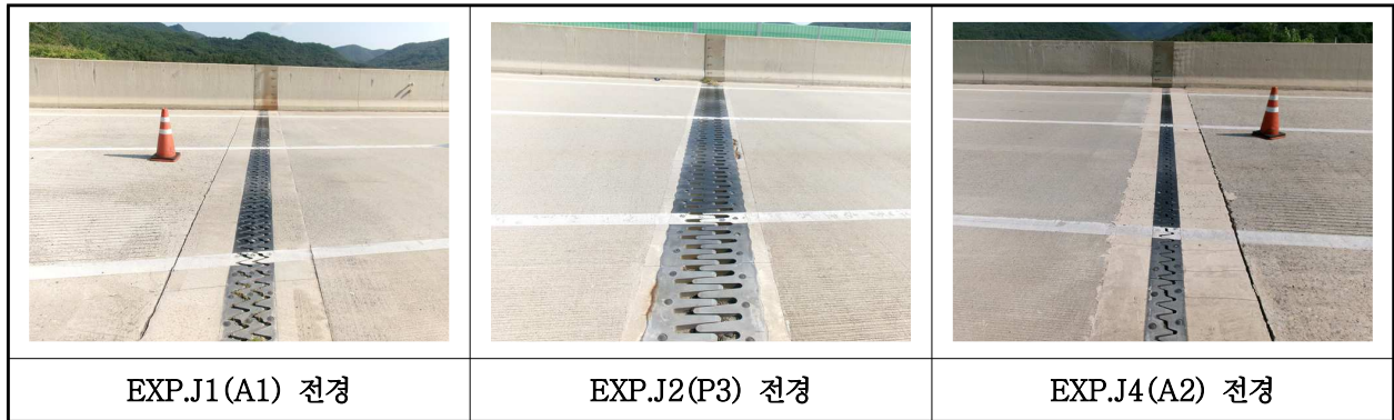
【사진 6.3.16】 신축이음장치 전경
